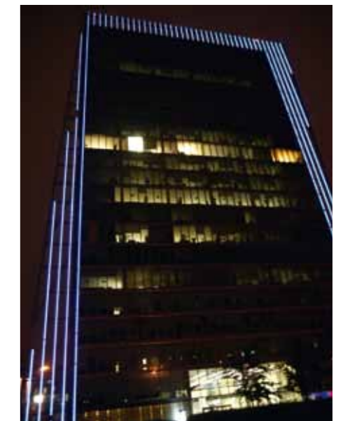
Etwa 1.000 Meter LED-Beleuchtung braucht es, um den stählernen Riesen zu erleuchten.
